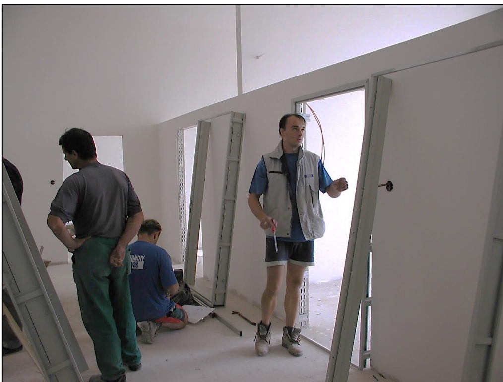
Generální rekonstrukce školy, chodba před místností školního poradenského pracoviště, pracovištěm účetní školy a ředitelnou...; foto archiv ZŠ Litomyšl, Zámecká 496
