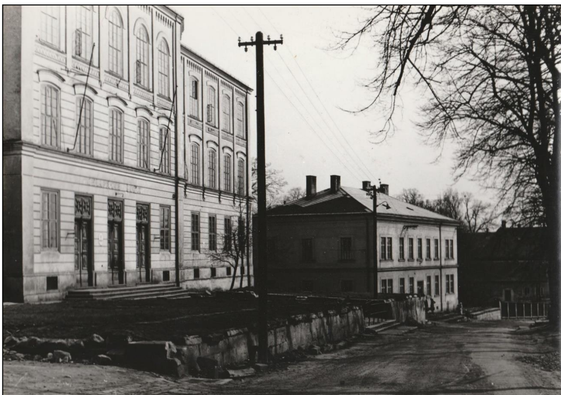
Zemní úpravy před budovou školy, 2. 4. 1959 (na budově již chybí nápis „Chlapecké školy“); foto soukromý archiv Zory Limberské, zapůjčeno od Lenky Backové
