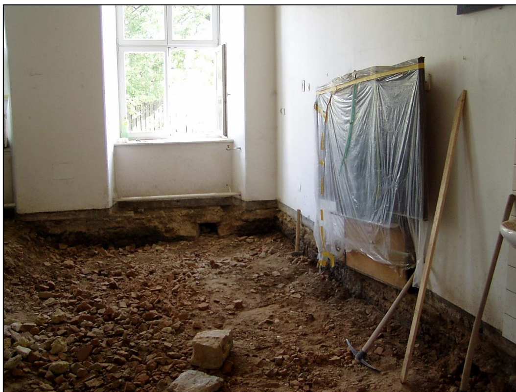
Rekonstrukce podlah v přízemí školy; foto archiv ZŠ Litomyšl, Zámecká 496
