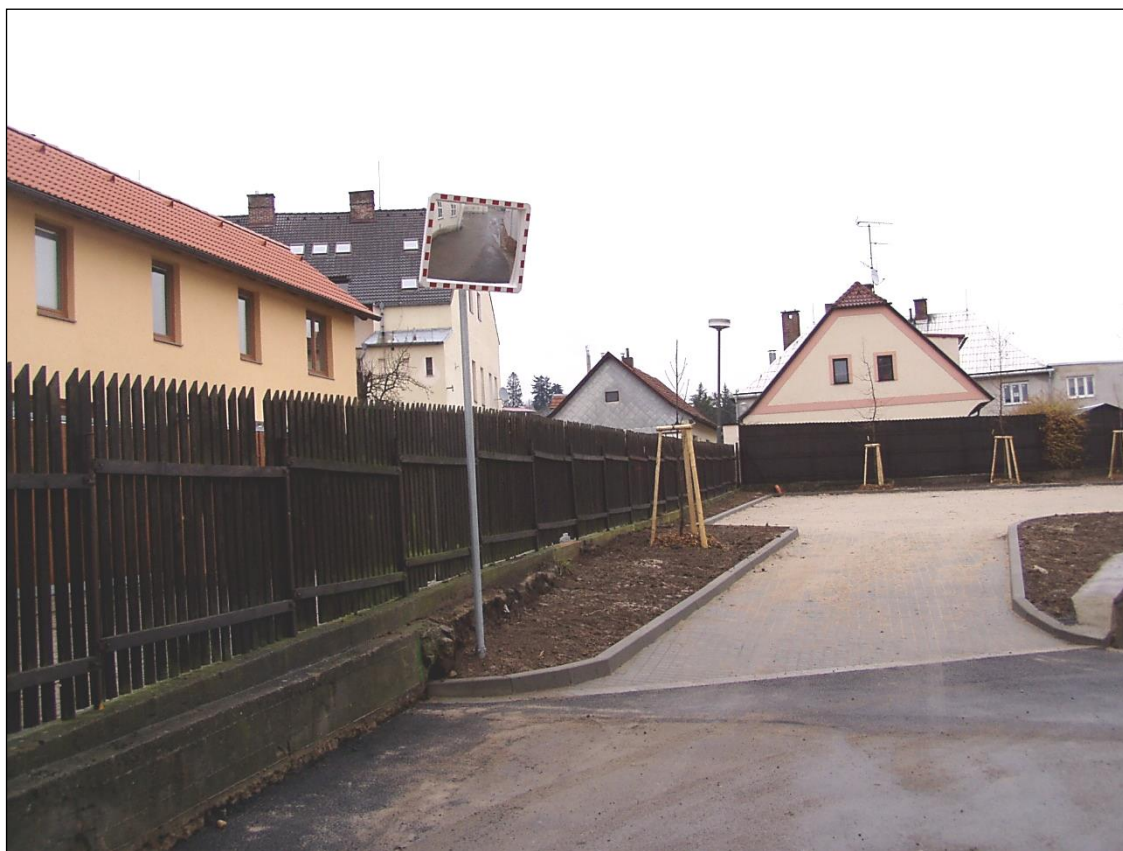
Vybudování parkoviště na nevyužívaném pozemku vedle školní jídelny; foto archiv ZŠ Litomyšl, Zámecká 496
