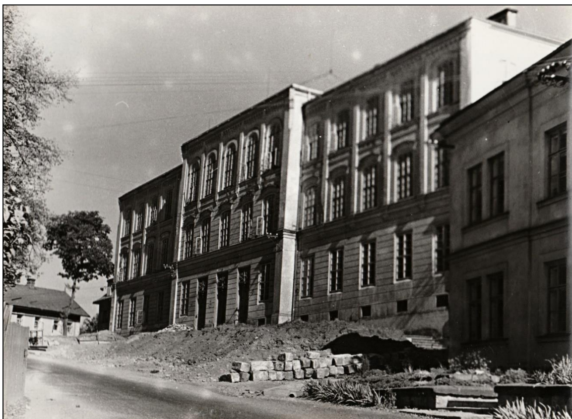
Zemní úpravy před budovou školy, 5. 10. 1959; foto soukromý archiv Zory Limberské, zapůjčeno od Lenky Backové
