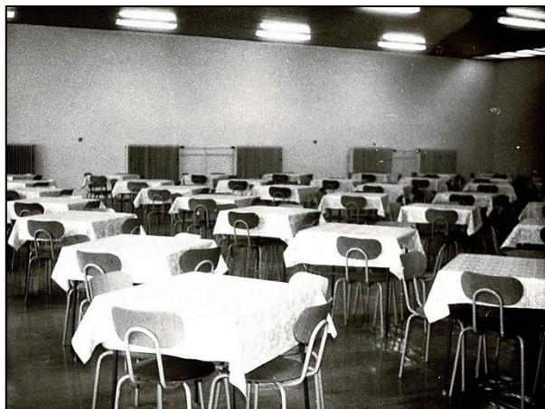
Interiér nové školní jídelny uvedené do provozu před polovinou 80. let; foto archiv ZŠ Litomyšl, Zámecká 496
