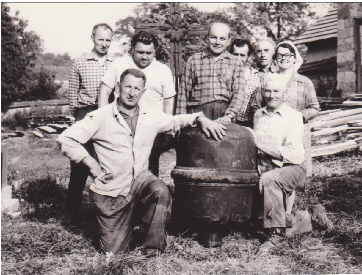
Erwin Kössler (zcela vlevo) při opravě kostela v Dětrichově, konec 70. let 20. st.
