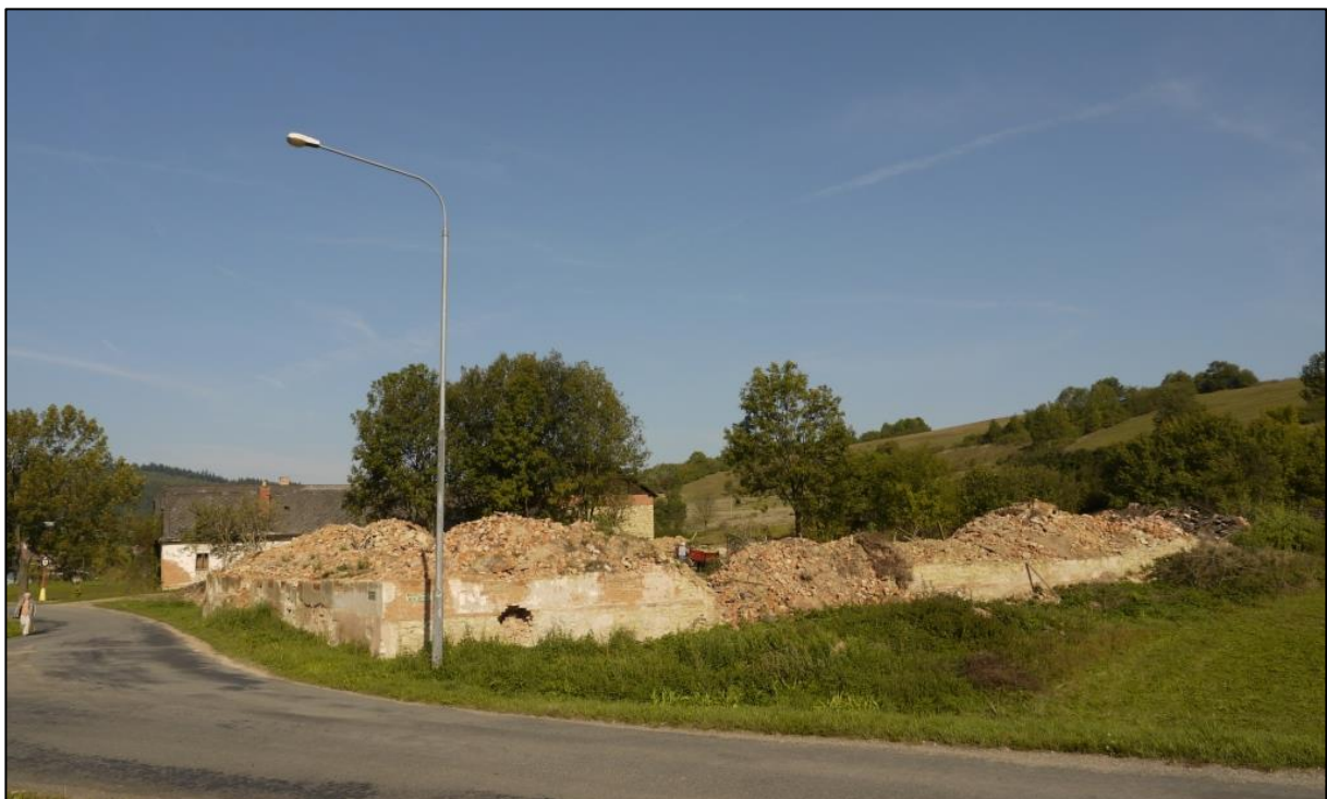
Strik-Gasthaus Rostitz - eingefallen und abgetragen, 2012
