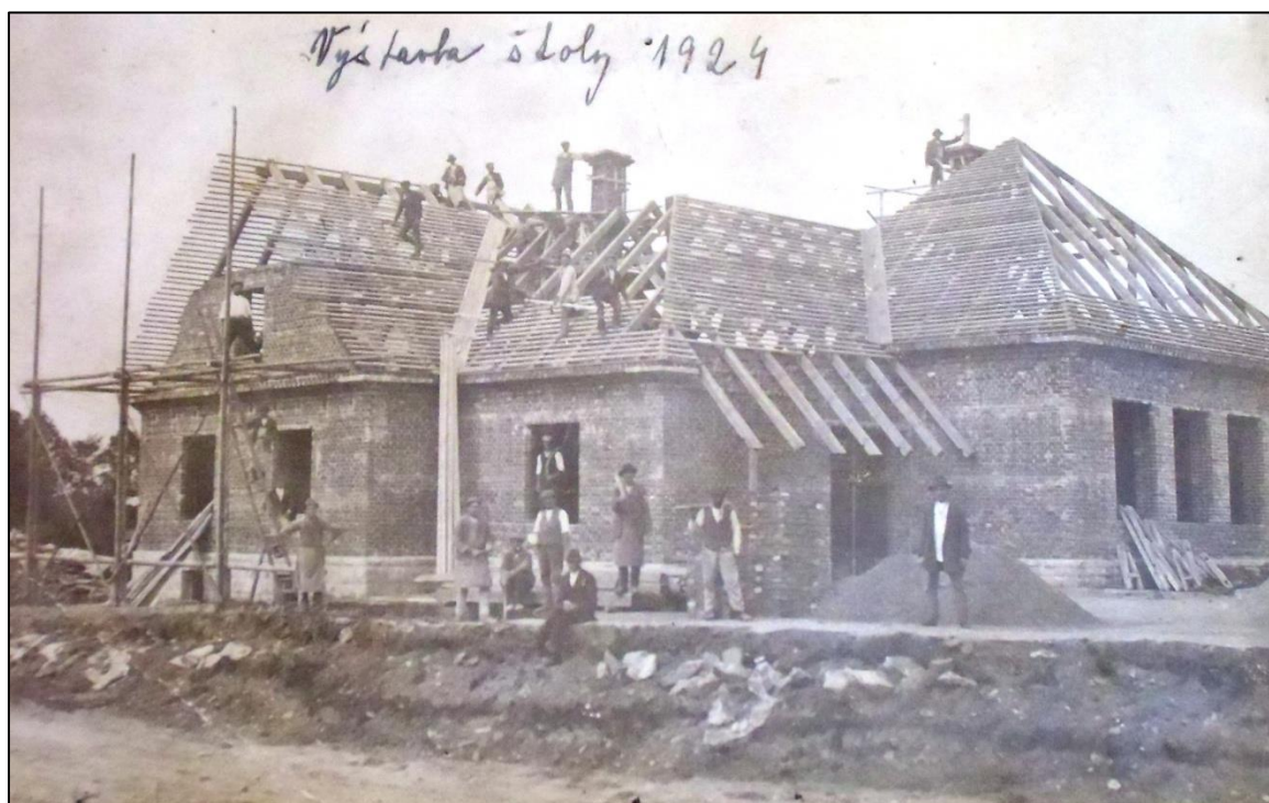
Výstavba české menšinové školy, první polovina 20. let 20. st.
