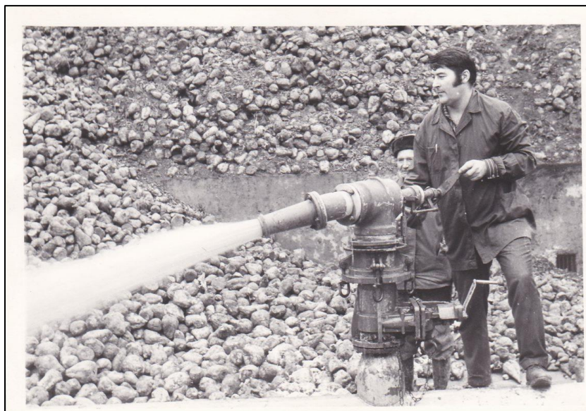
Foto 3: Václav Jozefy sráží vodním dělem cukrovku do dopravního kanálu - Cukrovar Hrochův Týnec
