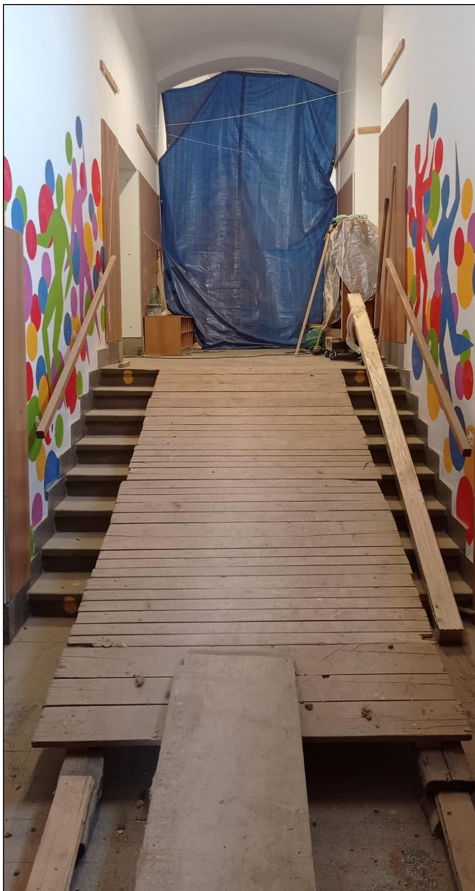
Rekonstrukce podlahy v učebně 116 byla nejnákladnější opravou, která v průběhu hlavních prázdnin 2023 proběhla
